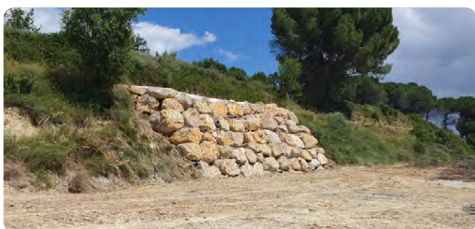
MUR DE SOUTÈNEMENT EN ENROCHEMENT LIEU DIT COURRÉGIS 33 433,08€
