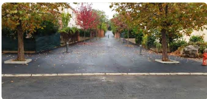
RÉFECTION DE L'ALLÉE PIÉTONNIÈRE LE VENTAJOU 27 951€
