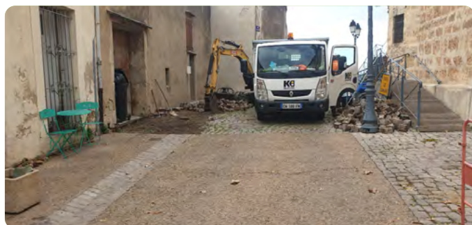
RÉFECTION DE LA VOIRIE EN BÉTON DÉSACTIVÉ DEVANT L'EGLISE 6933,40€
