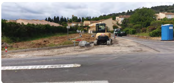
RÉFECTION ENTRÉE ST JEAN ET FONTAURY 25 892,40€
